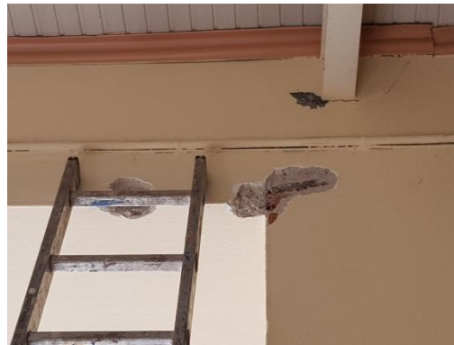
Εικόνα 77. Δοκός από σκυρόδεμα άνω των υποστυλωμάτων που χωρίζουν την είσοδο από την
