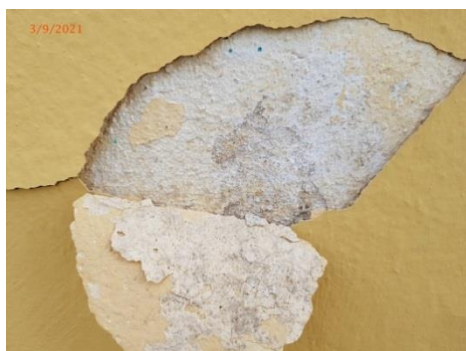
Εικόνα 56. Στρώσεις βαφής των όψεων – 1 ος όροφος
