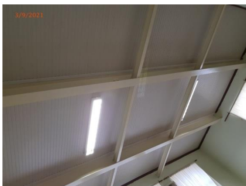
Εικόνες 6-8. Στατική ενίσχυση κτιρίου – εμφανής στο ισόγειο (χώροι I.4, I.1 & I.2)
