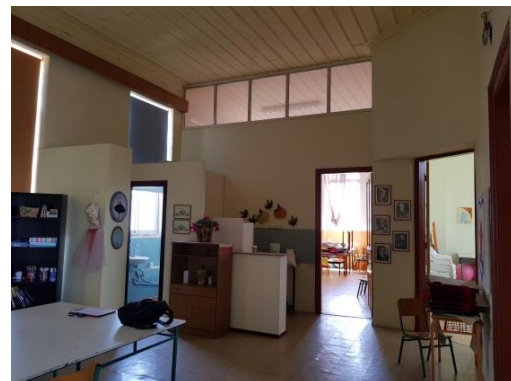
Εικόνα 105. Εσωτερικές διαρρυθμίσεις με γυψοσανίδα & πλαστικά πλακίδια δαπέδου
