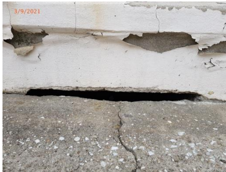
Εικόνα 51. Στρώσεις βαφής στη βάση του κτιρίου
