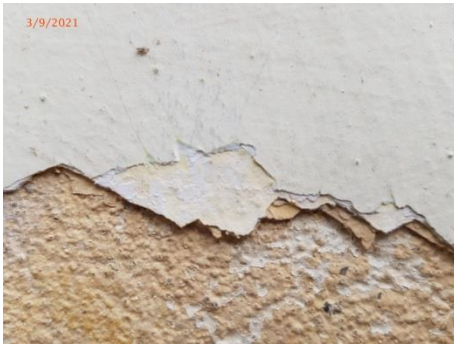
Εικόνα 50. Στρώσεις βαφής των όψεων ισογείου
