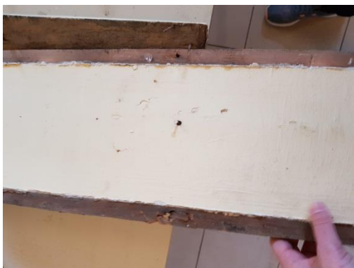
Εικόνα 87. Σανίδα οροφής 1 ου ορόφου
