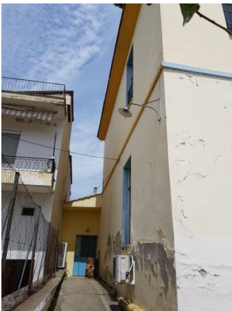
Εικόνα 37. Άποψη δυτικής όψης
