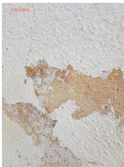
Εικόνα 57. Στρώσεις βαφής των όψεων – 1 ος όροφος
