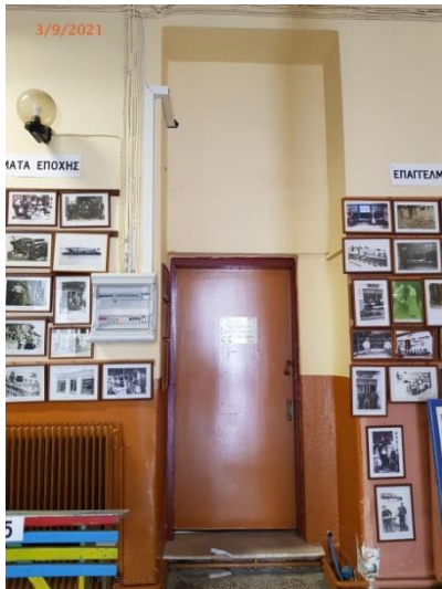
Εικόνα 14. Πίσω θύρα κτιρίου, της οποίας το άνοιγμα περιορίστηκε (χώρος Ι.4)
