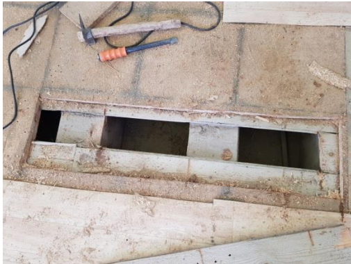
Εικόνα 83. Αποκάλυψη αυθεντικού ξύλινου δαπέδου ορόφου αι της κατασκευαστικής
