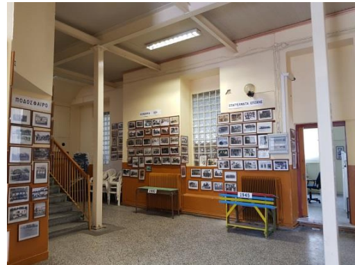
Εικόνα 103. Ανοίγματα διατηρητέου κτιρίου που έκλεισαν λόγω της προσθήκης του κλειστού
