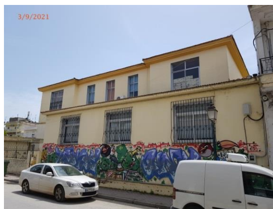
Εικόνα 23. Όψη προς οδό Ηφαιστου – Ισόγειο κεραμοσκεπές κτίριο (προσθήκη)
