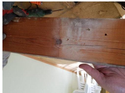
Εικόνα 109. Σανίδωμα δαπέδου 1 ου ορόφου (κάτω πλευρά)
