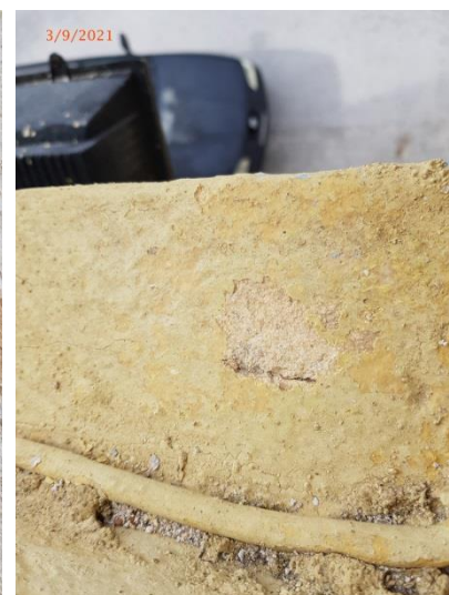
Εικόνα 58. Στρώσεις βαφής στο γείσο του 1 ου ορόφου
