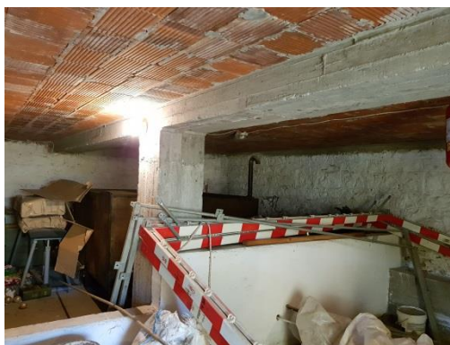
Εικόνα 10. Στατική ενίσχυση υπογείου
