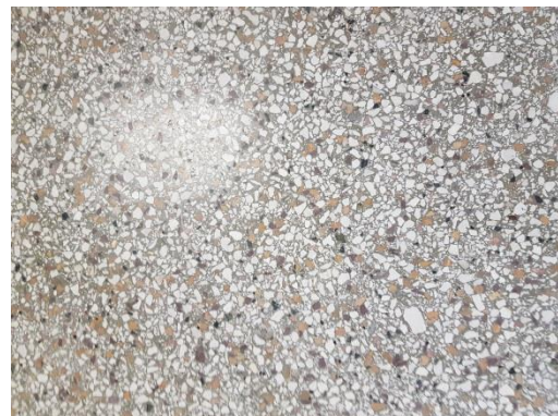
Εικόνα 82. Δάπεδο ισόγειου από μωσαϊκό
