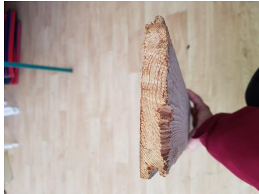
Εικόνα 84. Διατομή αυθεντικού ξύλινου ραμποτέ δαπέδου 1 ου
