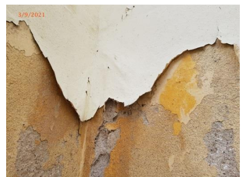
Εικόνα 55. Στρώσεις βαφής των όψεων ισογείου – κατώτερη στρώση
