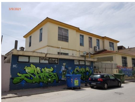
Εικόνα 24. Όψη προς οδό Ηφαιστου – Ισόγειο κτίριο χώρων υγιεινής (προσθήκη)
