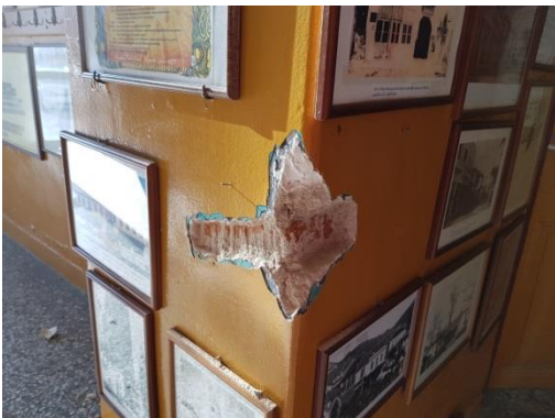
Εικόνες 72&73. Διαμόρφωση γωνίας με συμπαγείς οπτόπλινθους σε φέρουσα τοιχοποιία από λιθοδομή
