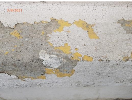
Εικόνα 53. Στρώσεις βαφής στο γείσο του ισογείου
