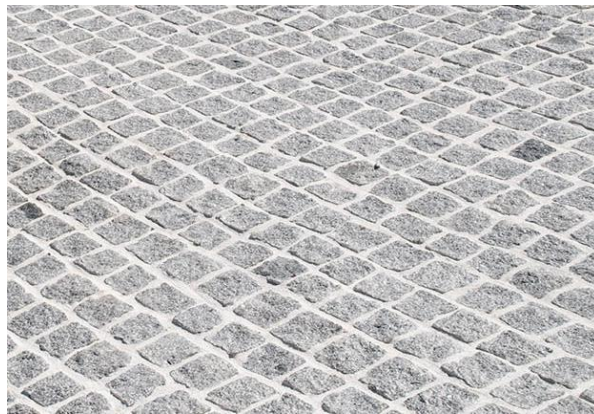
Εικόνα 127. Πλακόστρωτο με γκρι κυβόλιθους γρανίτη
