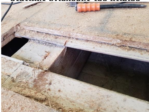
Εικόνα 108. Δοκοί δαπέδου 1 ου ορόφου
