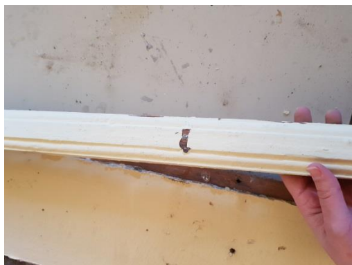
Εικόνα 88. Αρμοκάλυπτρο οροφής 1 ου ορόφου
