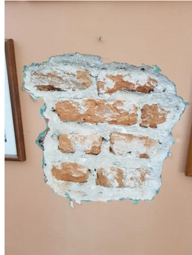
Εικόνα 75. Τοιχοποιίας από συμπαιγείς οπτόπλινθους μπατικής
