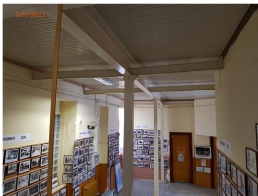
Εικόνα 5. Κάτοψη ισόγειου – Θέσεις μεταλλικών δοκών & υποστυλωμάτων στατικής ενίσχυσης κτιρίου
