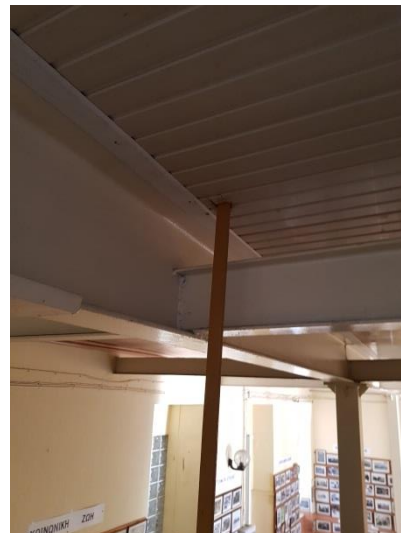
Εικόνα 91. Ανάρτηση κιγκλιδώματος κλιμακοστασίου από την οροφή του ισογείου
