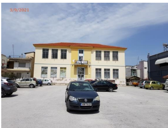
Εικόνα 22. Όψη προς οδό Βενιζέλου – Κεντρική είσοδος & αύλειος χώρος
