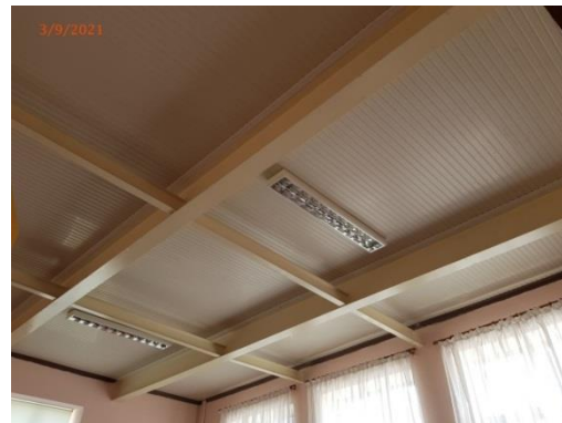
Εικόνες 6-8. Στατική ενίσχυση κτιρίου – εμφανής στο ισόγειο (χώροι I.4, I.1 & I.2)
