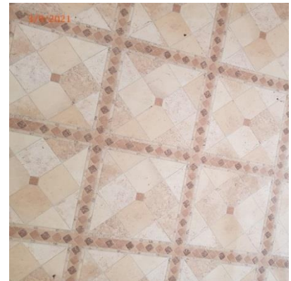
Εικόνες 16 & 17. Πλαστικά πλακίδια δαπέδου 1ου ορόφου
