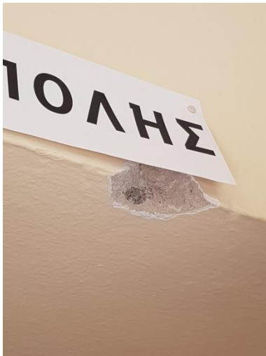
Εικόνα 76. Δοκός από σκυρόδεμα άνω των θυρών των αιθουσών
