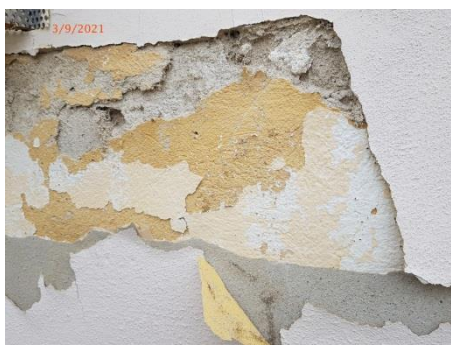
Εικόνα 54. Στρώσεις βαφής των όψεων ισογείου – κατώτερη στρώση
