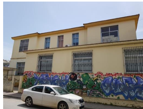
Εικόνα 36. Άποψη βόρειας όψης
