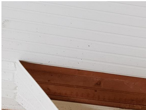
Εικόνα 85. Οροφή ισογείου από πλαστικό ραμποτέ και αποκάλυψη ξύλινης ραμποτέ οροφής πιθανόν μεταγενέστερης κατασκευής
