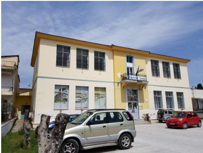
Εικόνα 11. Νέα κουφώματα αλουμινίου
