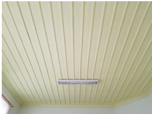
Εικόνα 86. Οροφή 1 ου ορόφου από ξύλινες σανίδες και αρμοκάλυπτρα
