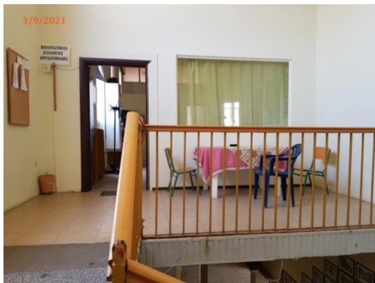
Εικόνα 18. Τοίχος γυψοσανίδας 1ου ορόφου (χώρος κλιμακοστασίου στον 1ο όροφο)
