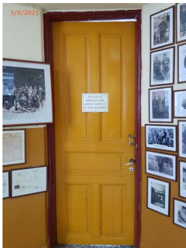
Εικόνα 45. Αυθεντικές εσωτερικές ταμπλαωτές πόρτες
