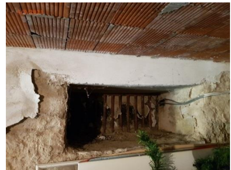
Εικόνες 40&41. Παράθυρα υπογείου τα οποία έχουν κλείσει λόγω της ανύψωσης του εδάφους της αυλής.
